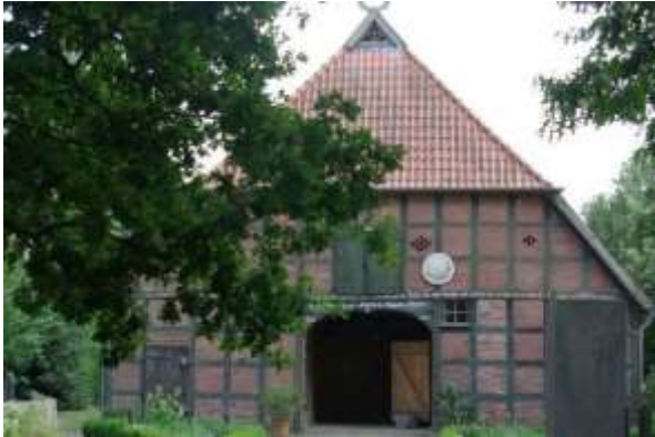
Fachwerk mit Ziegelausmauerung
