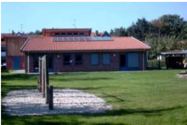
Solarkindergarten in Häuslingen
