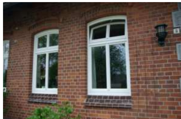
Erneuertes Fenster in Ziegelgebäude
